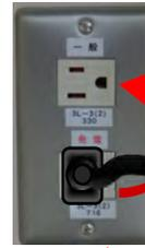
・普段は発電機回路なので、停電時に電源供給されます。発電機等の電気設備定期点検時(3年に1回)は、コンセントを発電機回路から一般回路に差し替えて下さい。
