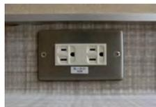
・床頭パネル側の足元に一般コンセントを設けております。電動ベッドの電源にご利用下さい。
